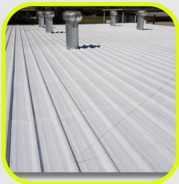
Termiprotec Aqua es un revestimiento protector, térmico e impermeabilizante acrílico elastomérico de un solo componente. Termiprotec Aqua al tener propiedades impermeabilizantes, impermeables y de elongación, además de una fuerte unión en la mayoría de los sustratos, al curar, forma un recubrimiento resistente, flexible y duradero que es resistente a los rayos UV y otros agentes climáticos.
